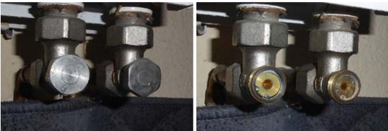
Der Zulauf wird mit Inbusschrauben abgesperrt, die hier noch mit Abdeckkappen gesichert sind. Zuerst müssen die Kappen abgedreht werden. Falls ein passender Inbusschlüssel vorhanden ist, so prüfen, ob die Schrauben geöffnet oder geschlossen sind (Anschlag rechts ist geschlossen nach links geöffnet). Ggf. beide Schrauben nach links drehen. Dann sollte der Heizkörper gehen.
